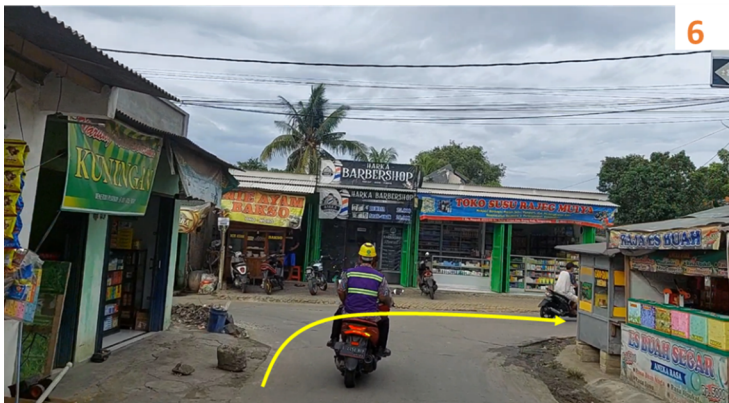
6 Rencana : Pemasangan pipa JDU diameter 300 mm, jalan rajeg mulya (area 4) (06°06'34"S 106°31'52"E) Metode : Boring manual Keterangan : Crossing jalan (pertigaan barbershop), reduce diameter pipa
