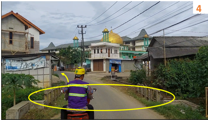
4 Rencana : Pemasangan pipa JDU diameter 355 mm, jalan rajeg mulya (area 4) (06°06'48"S 106°31'34"E) Metode : Boring manual Keterangan : Jembatan irigasi
