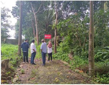
Akses Jalan Menuju Lokasi Reservoir Setuk
