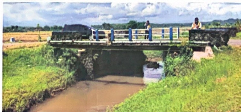
Gambar 3 : Kondisi eksisting pipa lama di avfour rowo remang
