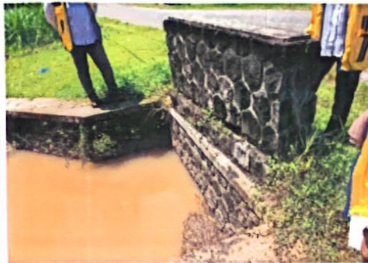
Gambar 4 : Kondisi eksisting pipa lama di saluran sekunder rejtangan ruas 1
