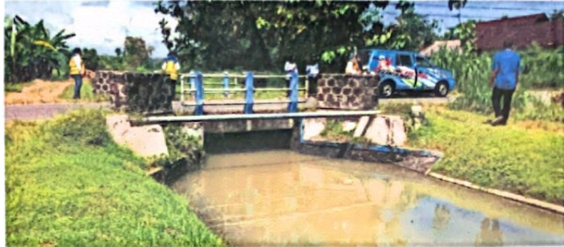
Gambar 2 : Kondisi eksisting pipa lama di saluran sekunder rowo remang ruas 3
