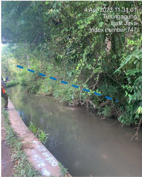
Pengadaan dan Pemasangan Pipa Transmisi GI 300 mm (expose dengan pondasi support) - Saluran Irigasi SDA Kabupaten
