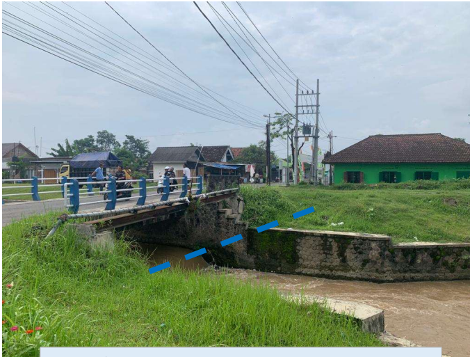
Pipa Ø 110 mm di Saluran BBWS Brantas dengan pengadaan abutment.
