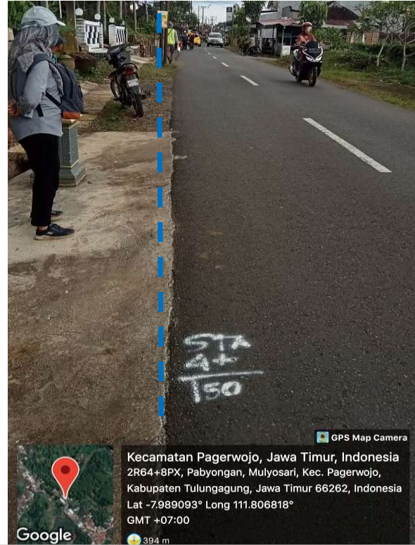
Jalur Pipa Transmisi PVC 300 (metode open cut) - Jalan Kabupaten
