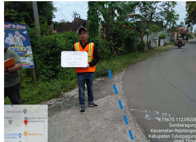
Jalur Pipa PVC Ø 160 mm (Pengganti Pipa Eksisting ACP) metode boring manual di Jalan Kabupaten.
