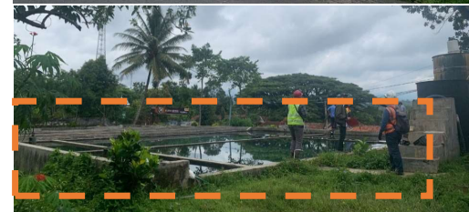
Bangunan Eksisting IPA Mulyosari kapasitas 100 L/det pada Kawasan Perhutani - DDUB
