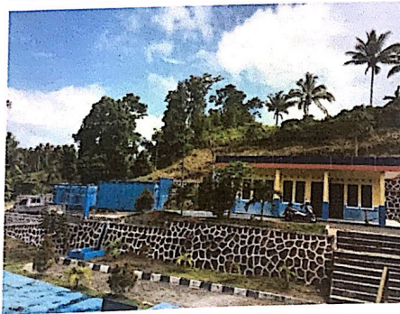
Instalasi Pengolahan Air (IPA) Kumersot
