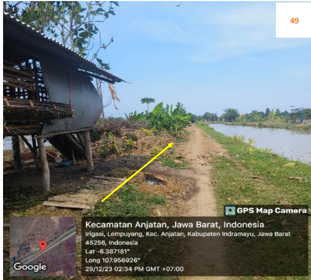
Rencana : Pemasangan Pipa JDU HDPE Ø 200 mm Jalan Irigasi lempuyang (-6.387181,107.956926) 2+400 Metode : Open Cut Keterangan : Kandang Kambing
