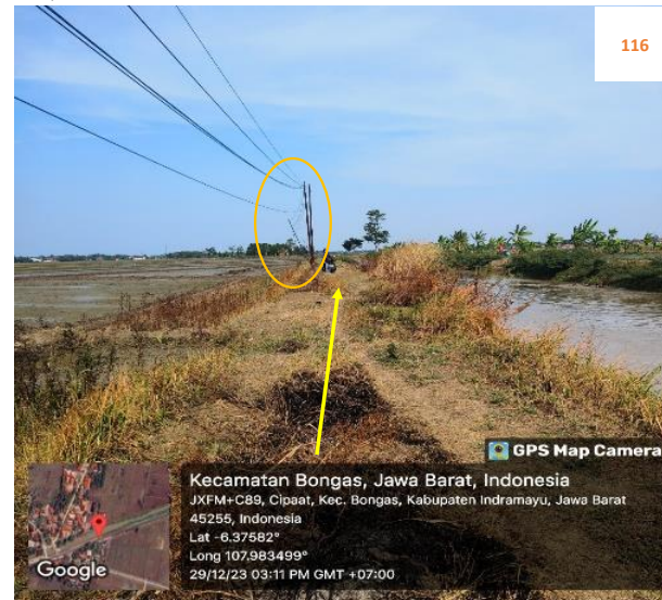
Rencana : Pemasangan Pipa JDU HDPE Ø 200 mm Jalan irigasi Cipaat (-6.37582,107.983499) 5+750 Metode : Open Cut Keterangan : Tiang Telpon
