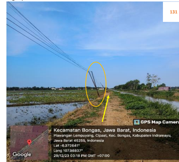
Rencana : Pemasangan Pipa JDU HDPE Ø 200 mm Jalan irigasi Cipaat (-6.372641,107.98837) 6+550 Metode : Open cut Keterangan : Tiang Telpon
