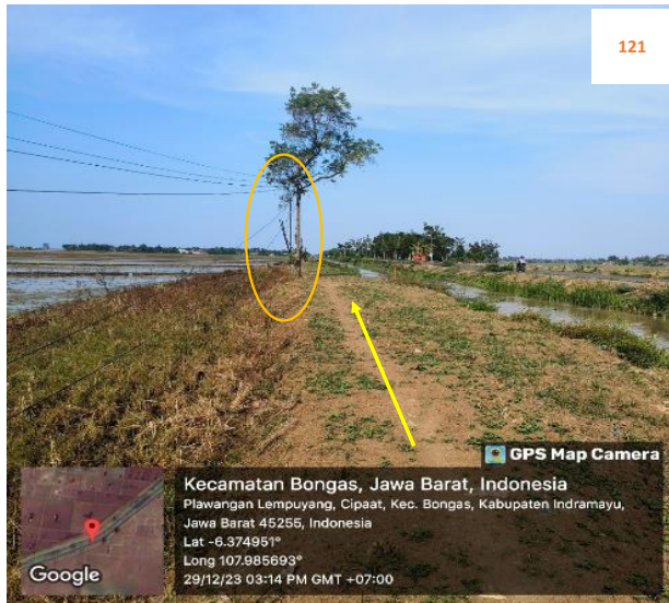
Rencana : Pemasangan Pipa JDU HDPE Ø 200 mm Jalan irigasi Cipaat (-6.374951,107.985693) 6+00 Metode : Open Cut Keterangan : Tiang Telpon
