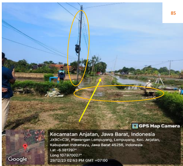
Rencana : Pemasangan Pipa JDU HDPE Ø 200 mm Jalan Irigasi lempuyang (-6.381297,107.970027) 4+200 Metode : Open Cut dan Syphon - 3 m Keterangan : Tiang Telpon, Pintu air, Gorong-gorong air
