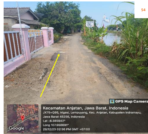
Rencana : Pemasangan Pipa JDU HDPE Ø 200 mm Jalan Irigasi lempuyang (-6.385942,107.958691) 2+650 Metode : Open Cut Keterangan : Jalan aspal
