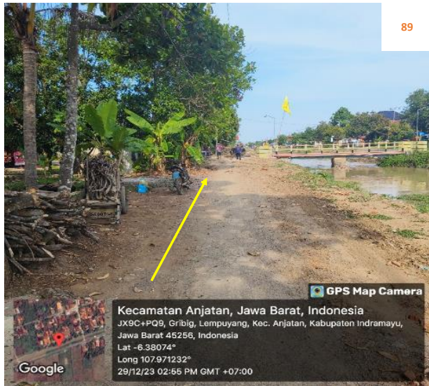
Rencana : Pemasangan Pipa JDU HDPE Ø 200 mm, Jalan irigasi lempuyang (-6.38074,107.971232) 4+400 Metode : Open cut Keterangan : Aman, Tidak ada utilitas
