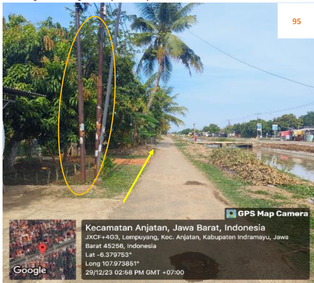
Rencana : Pemasangan Pipa JDU HDPE Ø 200 mm Jalan irigasi lempuyang (-6.379753,107.973851) 4+700 Metode : Open Cut Keterangan : tiang telpon
