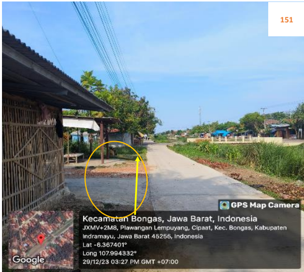
Rencana : Pemasangan Pipa JDU HDPE Ø 200 mm Jalan irigasi Cipaat (6.367401,107.994332) 7+500 Metode : Open Cut, Crossing Keterangan : rumah warga, jalan beton
