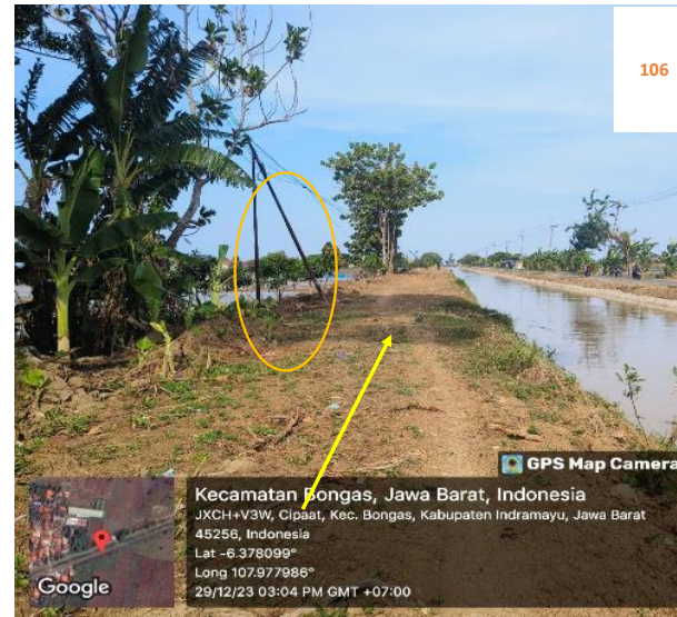
Rencana : Pemasangan Pipa JDU HDPE Ø 200 mm Jalan irigasi Cipaati (-6.378099,107.977986) 5+250 Metode : Open Cut Keterangan : Tiang Telpon
