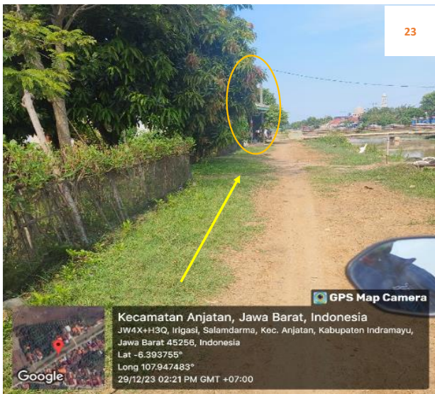
Rencana : Pemasangan Pipa JDU HDPE Ø 200 mm Jalan Irigasi salam darma (-6.393755,107.947483) 1+100 Metode : Open Cut Keterangan : Tiang listrik
