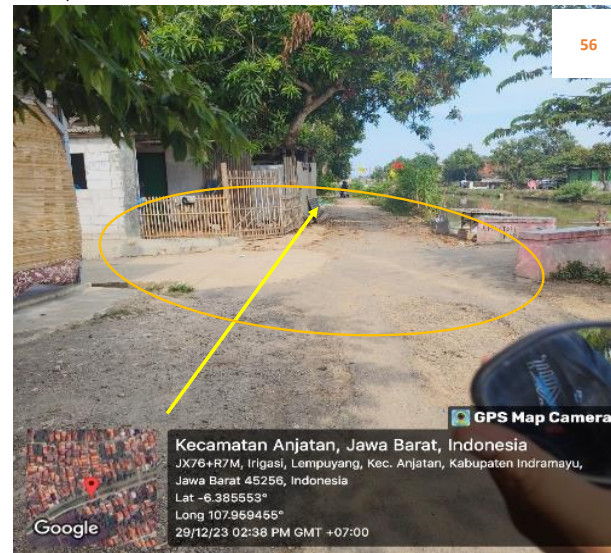
Rencana : Pemasangan Pipa JDU HDPE Ø 200 mm Jalan Irigasi lempuyang (-6.385553,107.959455) 2+750 Metode : Open Cut dan Crossing - 2,50 m Keterangan : Jembatan , Persimpangan
