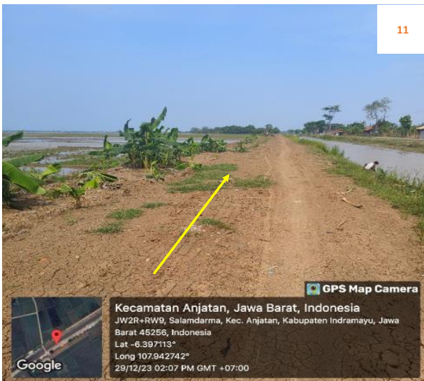
Rencana : Pemasangan Pipa JDU HDPE Ø 200 mm Jalan Irigasi salam darma (-6.397113,107.942742) 0+500 Metode : Open Cut Keterangan : Aman, Tidak ada utilitas
