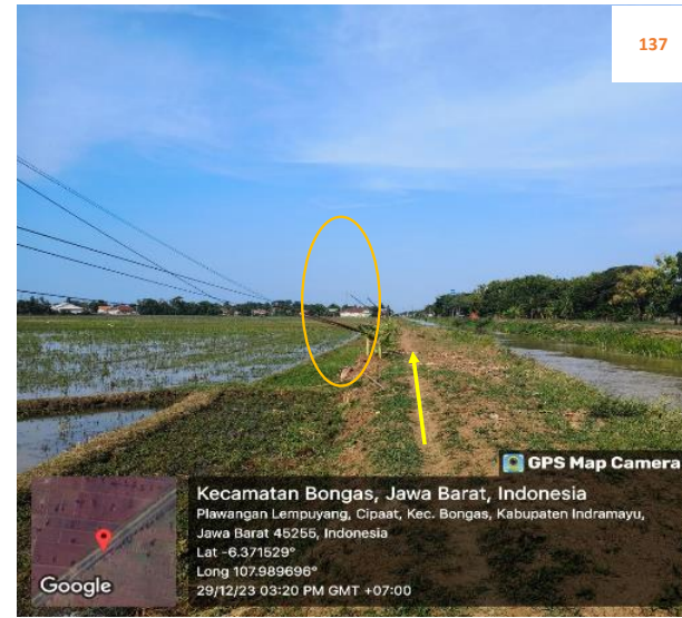
Rencana : Pemasangan Pipa JDU HDPE Ø 200 mm Jalan irigasi Cipaat (-6.371529,107.989696) 6+850 Metode : Open Cut Keterangan : Tiang Telpon
