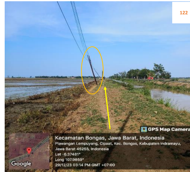
Rencana : Pemasangan Pipa JDU HDPE Ø 200 mm Jalan irigasi Cipaat (-6.37481,107.9859) 6+50 Metode : Open Cut Keterangan : Tiang Telpon
