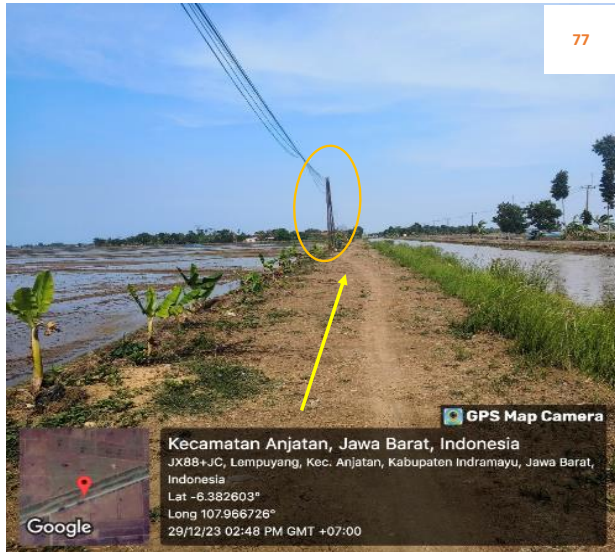
Rencana : Pemasangan Pipa JDU HDPE Ø 200 mm Jalan Irigasi lempuyang (-6.382603,107.966726) 3+800 Metode : Open Cut Keterangan : Tiang Telpon
