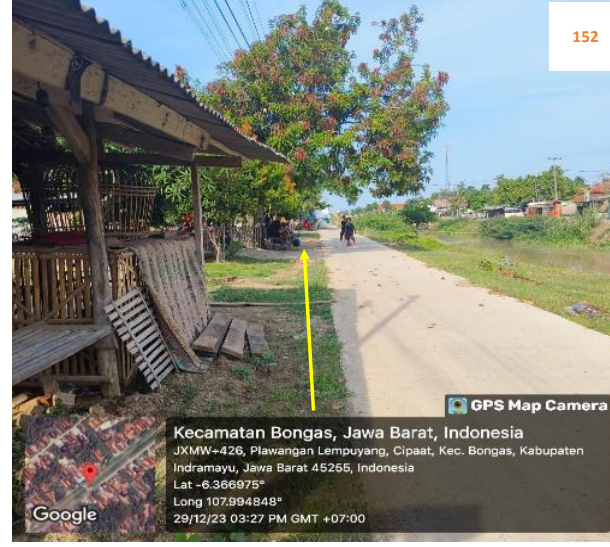
Rencana : Pemasangan Pipa JDU HDPE Ø 200 mm Jalan irigasi Cipaat (-6.366975,107.994848) 7+550 Metode : Open Cut Keterangan : rumah warga, jalan beton
