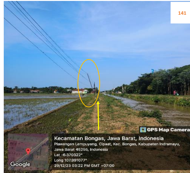
Rencana : Pemasangan Pipa JDU HDPE Ø 200 mm Jalan irigasi Cipaat (-6.370322,107.991077) 7+50 Metode : Open Cut Keterangan : Tiang Telpon
