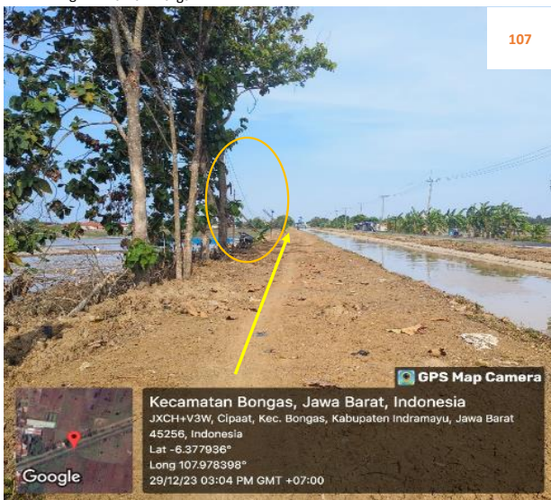
Rencana : Pemasangan Pipa JDU HDPE Ø 200 mm Jalan irigasi Cipaati (-6.377936,107.978398) 5+300 Metode : Open Cut Keterangan : Tiang Telpon
