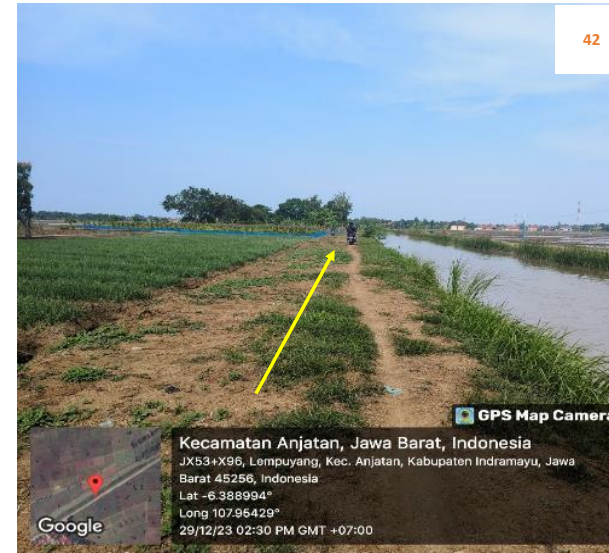
Rencana : Pemasangan Pipa JDU HDPE Ø 200 mm Jalan Irigasi lempuyang (-6.388994,107.95429) 2+50 Metode : Open Cut Keterangan : Aman, Tidak ada utilitas
