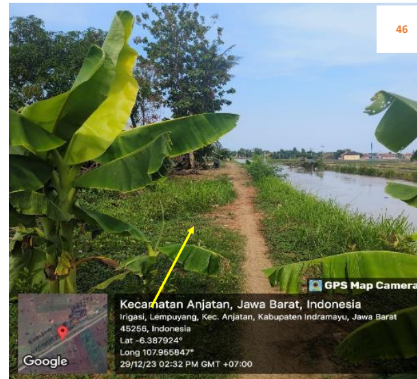
Rencana : Pemasangan Pipa JDU HDPE Ø 200 mm Jalan Irigasi lempuyang (-6.387924,107.955847) 2+250 Metode : Open Cut Keterangan : Aman, Tidak ada utilitas
