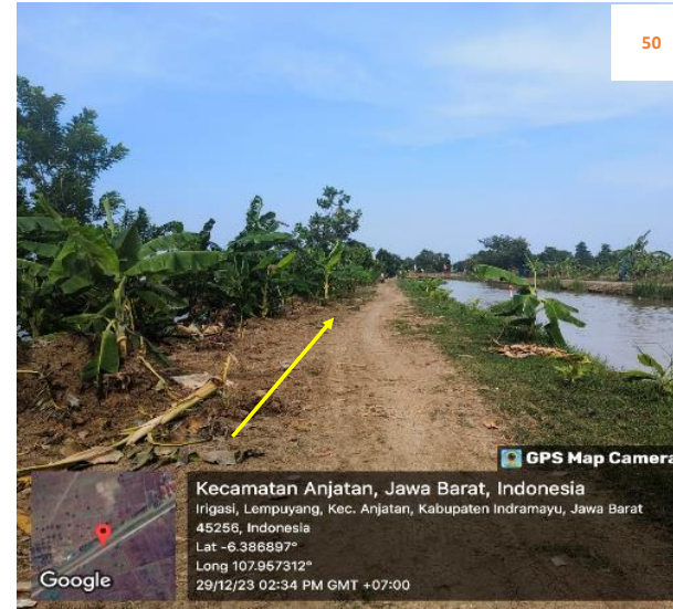
Rencana : Pemasangan Pipa JDU HDPE Ø 200 mm Jalan Irigasi lempuyang (-6.386897,107.957312) 2+450 Metode : Open Cut Keterangan : Aman, Tidak ada utilitas
