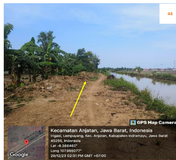
Rencana : Pemasangan Pipa JDU HDPE Ø 200 mm Jalan Irigasi lempuyang (-6.388462,107.955077) 2+150 Metode : Open Cut Keterangan : Aman, Tidak ada utilitas
