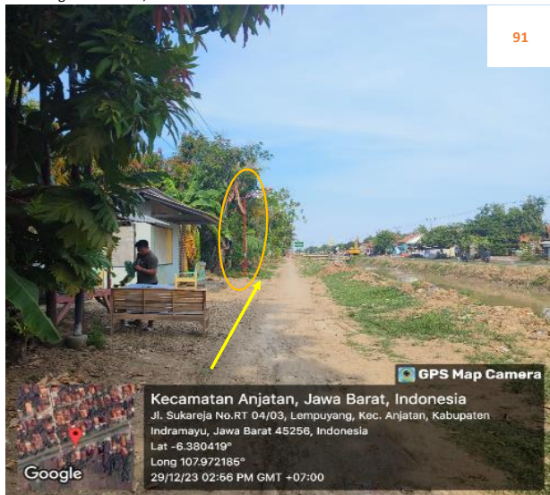
Rencana : Pemasangan Pipa JDU HDPE Ø 200 mm, Jalan irigasi lempuyang (-6.380419,107.972185) 4+500 Metode : Open cut Keterangan : Tiang PJU
