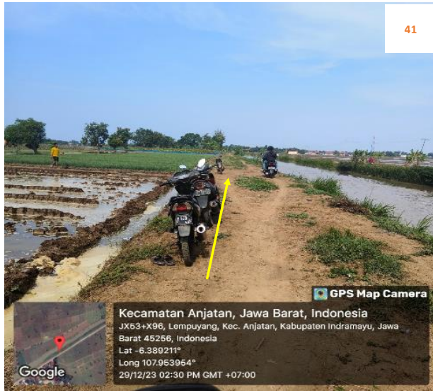
Rencana : Pemasangan Pipa JDU HDPE Ø 200 mm Jalan Irigasi lempuyang (-6.389211,107.953954) 2+00 Metode : Open Cut Keterangan : Aman, Tidak ada utilitas
