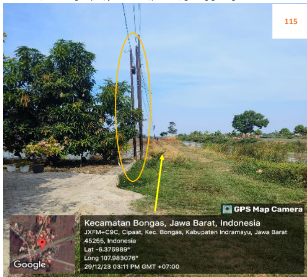
Rencana : Pemasangan Pipa JDU HDPE Ø 200 mm Jalan irigasi Cipaat (-6.375989,107.983076) 5+700 Metode : Open Cut Keterangan : Tiang Telpon
