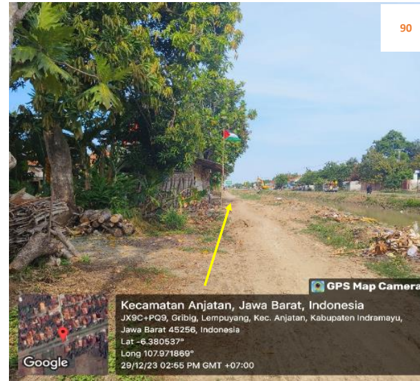
Rencana : Pemasangan Pipa JDU HDPE Ø 200 mm, Jalan irigasi lempuyang (-6.380537,107.971869) 4+450 Metode : Open cut Keterangan : Aman, Tidak ada utilitas
