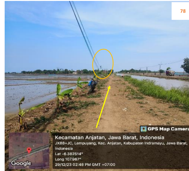
Rencana : Pemasangan Pipa JDU HDPE Ø 200 mm Jalan Irigasi lempuyang (-6.382514,107.967) 3+850 Metode : Open Cut Keterangan : Tiang Telpon
