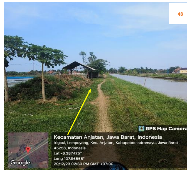
Rencana : Pemasangan Pipa JDU HDPE Ø 200 mm Jalan Irigasi lempuyang (-6.387425,107.95655) 2+350 Metode : Open Cut Keterangan : Aman, Tidak ada utilitas
