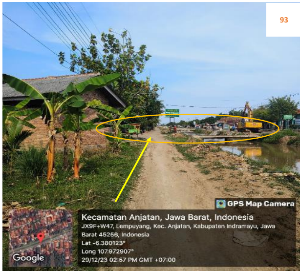
Rencana : Pemasangan Pipa JDU HDPE Ø 200 mm , Jalan irigasi lempuyang (-6.380123,107.972907) 4+600 Metode : Open cut dan Crossing Keterangan : Pertigaan dan jembatan jalan
