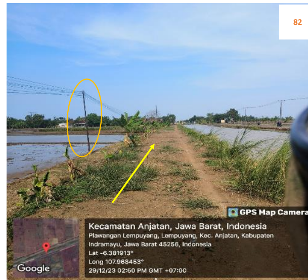
Rencana : Pemasangan Pipa JDU HDPE Ø 200 mm Jalan Irigasi lempuyang (-6.381913,107.968453) 4+50 Metode : Bor Manual 3 M Keterangan : Tiang Telpon
