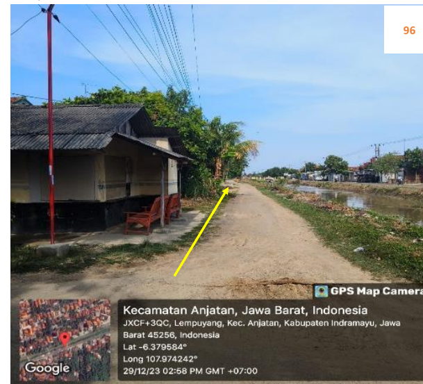
Rencana : Pemasangan Pipa JDU HDPE Ø 200 mm Jalan irigasi lempuyang (-6.379584,107.974242) 4+750 Metode : Open Cut Keterangan : Aman, Tidak ada utilitas
