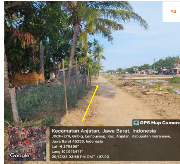
Rencana : Pemasangan Pipa JDU HDPE Ø 200 mm Jalan irigasi lempuyang (-6.379898,107.973471) 4+650 Metode : Open Cut Keterangan : Aman, Tidak ada utilitas
