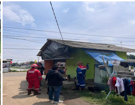
Gambar 3. Lokasi Penggalan Pipa
